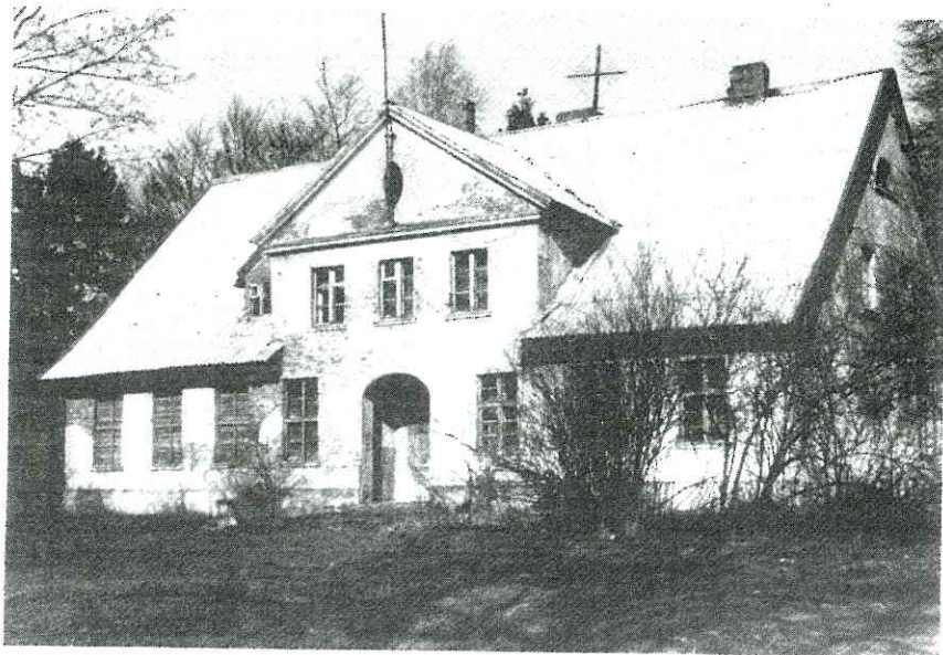
Haus der Wiederaufbauzeit (heute) bei Bladian, Krs. Heiligenbeil, die Bauinschrift nennt 1915 als Errichtungsjahr
